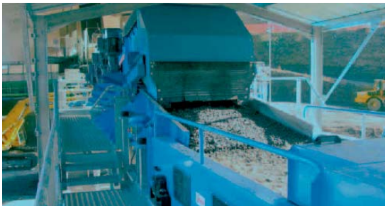
Abbildung 28: Aufbereitung von MVA-Schlacke für die Metallrückgewinnung. Ein Brecher zerkleinert die vorsortierte Schlacke auf wenige Millimeter [Jordi 2005].
