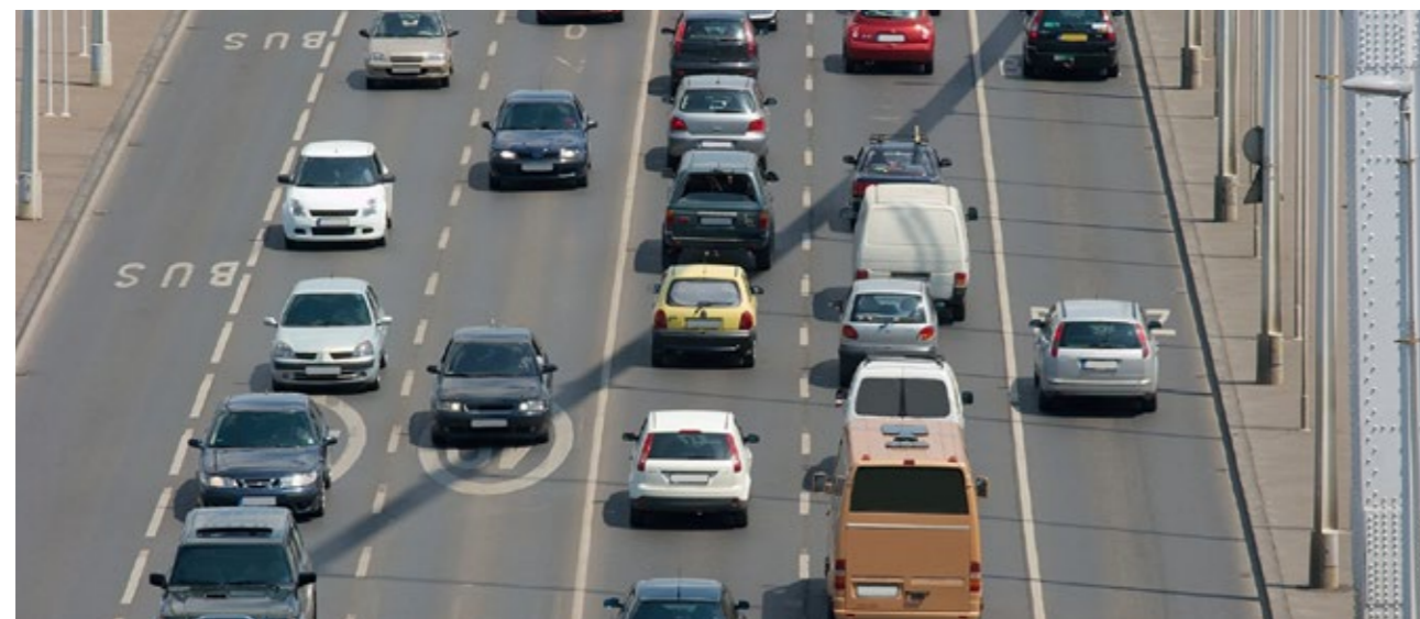
Abbildung 8: Brückenschäden können mit den Smartphones fortwährend erfasst werden. Quelle: © panthermedia.net/Gudella
